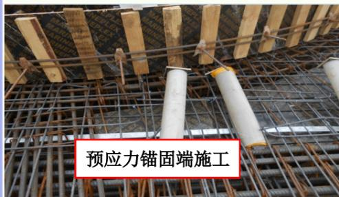
板中无粘结钢绞线用于控制顶板温度应力及混凝土收缩应力引起
