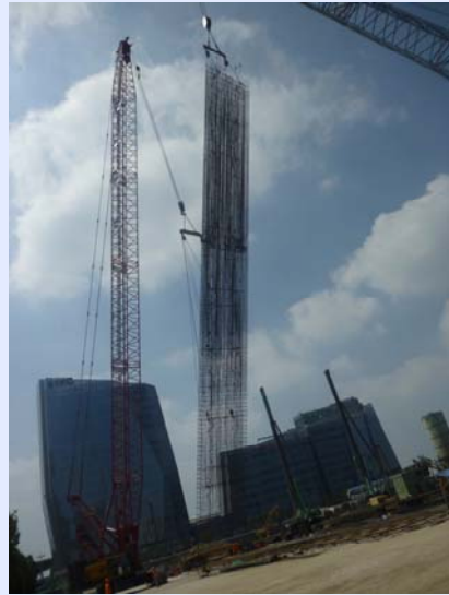
上图为地下连续墙钢筋网片起吊点图 片用两台履带吊起吊过程
