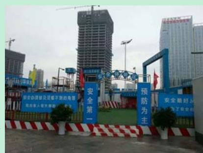
上图为某项目在现场专门设置的安全体检区
