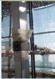
点支承玻璃幕墙外脚手架连墙件改成上图形式
