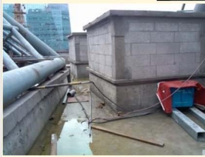
上图为悬挑卸料平台上堆放的模板高度超过两侧的防护栏杆,存在安全隐患。
