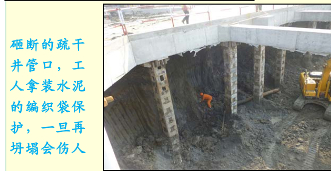
土方开挖不放坡，土方边坡坍塌把疏干井管子砸断
