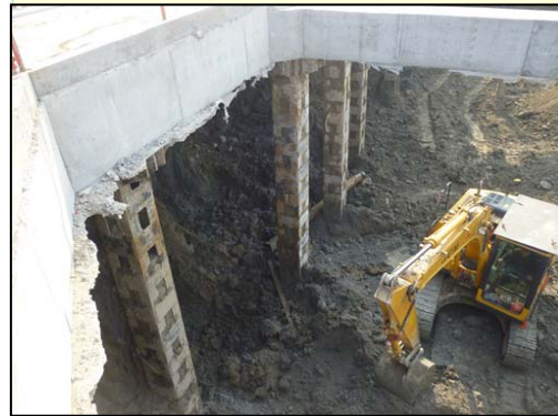
土方开挖不放坡，土方边坡坍塌把疏干井管子砸断
