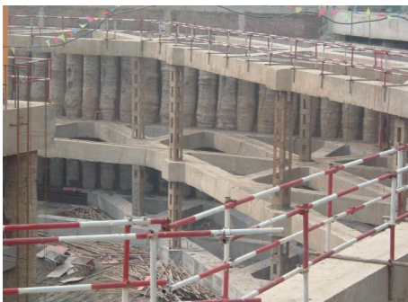
左图为深基坑围护三道支撑一角撑局部图片，大家先有一个感性认识，以后将陆续结合图片来介绍深基坑施工安全方面需注意的一些问题，供学习讨论。
